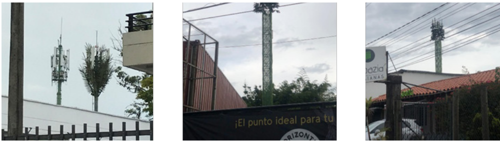
Figura 22. Antenas tipo palmera en Rionegro (Antioquia)
