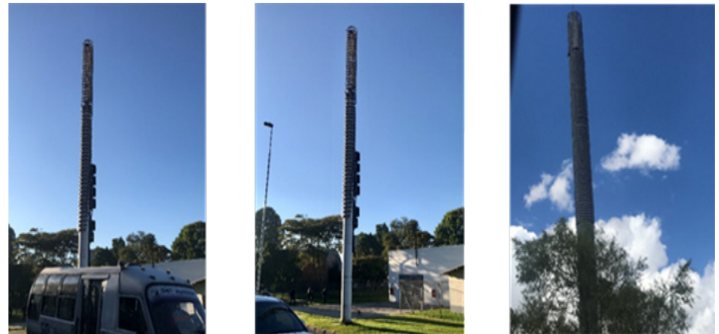
Figura 24. Antenas mimetizadas en postes- Aeropuerto El Dorado, Bogotá
